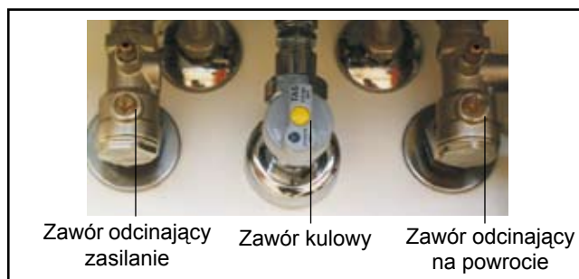
Rys: Urządzenia odcinające
