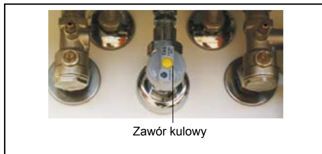
Rys: Urządzenia odcinające
