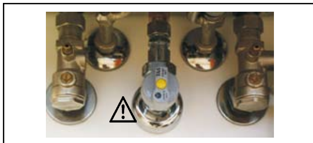
Przylączy gazu. Niebezpieczeństwo zatrucia gazem lub jego wybuchem.
