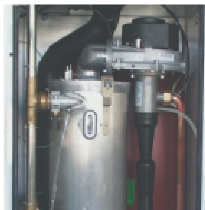
Rys.: Transformator zapłonowy, wysokonapięciowa elektroda zapłonowa, komora spalania
