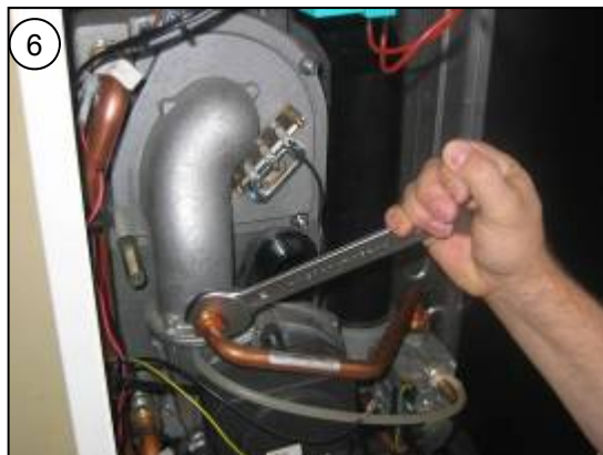
Odkręcić nakrętki łączkowe ścieżki gazowej, odłączyć rurę gazową, wyjąć dyszę gazową i uszczelkę z kanału mieszania
