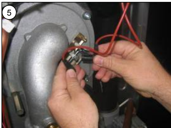
Zdjąć wtyczkę elektrody zapłonowej i wtyczkę uziemienia
