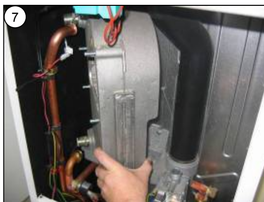
Lekko przechylić wymiennik ciepła i obrócić go o ok. 45° w kierunku zgodnym z ruchem wskazówek zegara, następnie wyjąć z obudowy
