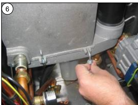
Zwolnić haki mocujące na kolektorze spalin i zdjąć go ku przodowi
