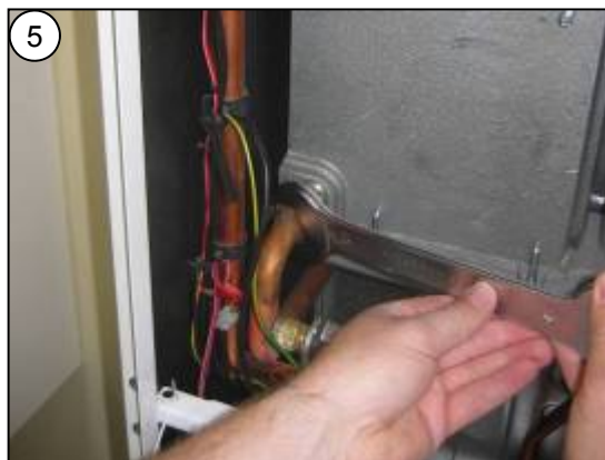
Rozkręcić śrubunki zasilania i powrotu na wymienniku ciepła
