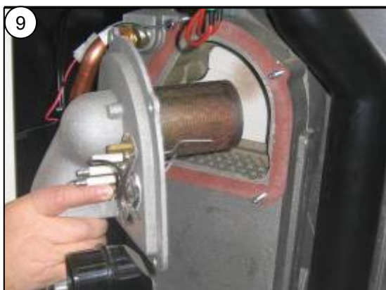
Wyjąć cały zespół palnika wraz z kanałem mieszania i wentylatorem
